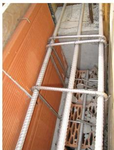
Le armature metalliche nelle zone sensibili sono state realizzate con un acciaio austenitico paramagnetico che non è magnetizzabile per evitare le alterazioni del campo elettromagnetico naturale della terra causate dagli anelli metallici chiusi dei ferri dei cordoli. Particolari soluzioni sono state utilizzate per interrompere in sicurezza la continuità dei ferri dei cordoli.
