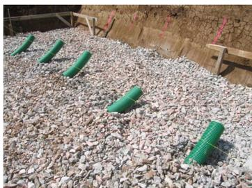
Tutto il processo di costruzione ha privilegiato l'attenzione alla salute degli abitanti; sotto la platea di fondazione è stato realizzato un sistema di ventilazione per lo smaltimento contemporaneo sia dell'umidità che del gas radon (naturale, radioattivo, pericoloso se si insacca nei vespai).
