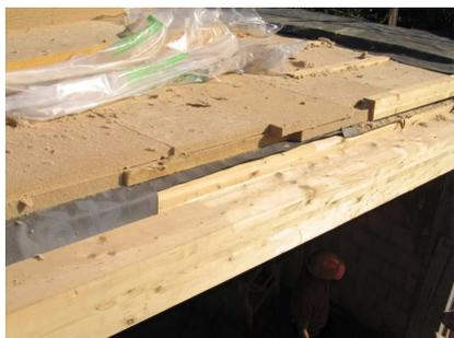
La copertura a doppia ventilazione è stata isolata con 16 centimetri di isolante naturale in fibra di legno ecologico, privo di collanti sintetici, e protetta con guaine speciali microforate traspiranti per garantire lo smaltimento del vapore acqueo.
